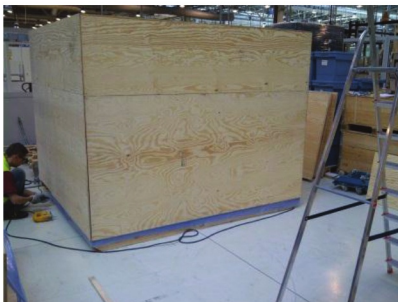
8. Zabezpieczenie warstwą sklejki wodoodpornej – gotowa skrzynia
